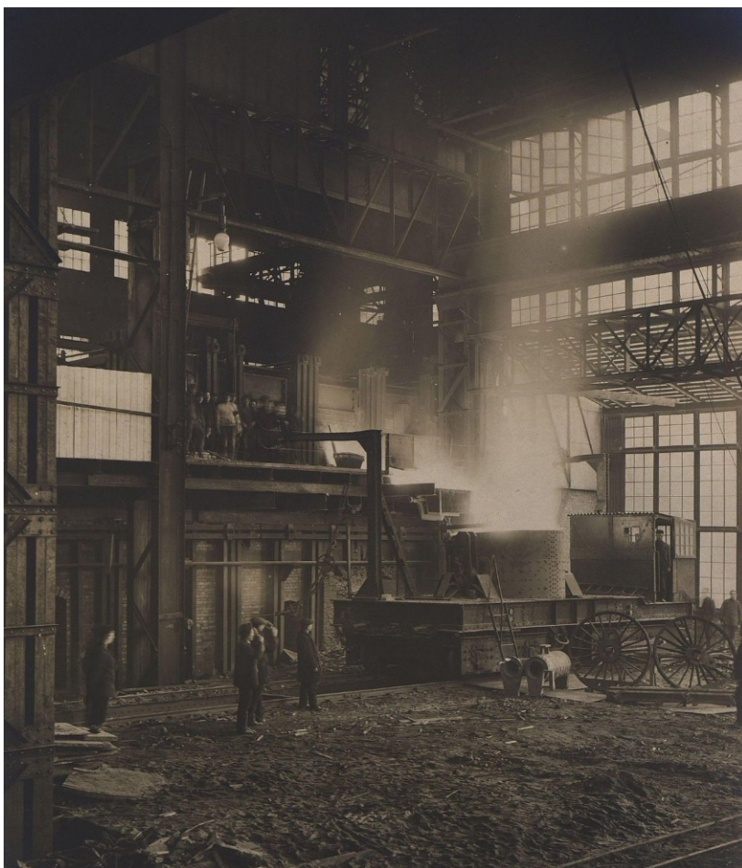
Мартеновская мастерская Путиловского завода. 40-тонная печь и ковш с электрической передвижной тележкой [4].
