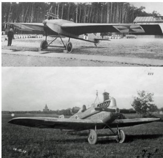
Цельнометаллические самолеты Х. Юнкера: из стали - J 1 (вверху) и алюминия - J 7 [42, 43].
