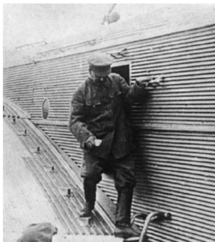
И.В. Сталин спускается на землю по крылу ТБ-3 после инспекции кабины пилотов. На фото отчетливо видна гофрированная обшивка фюзеляжа и крыльев из дюралюмина Д1 [94].
